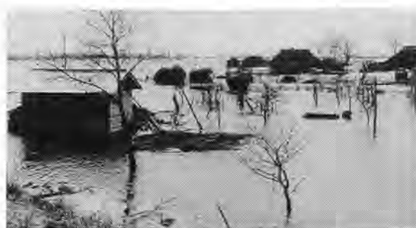
融雪洪水（昭和25年4月2日、新十川左岸 現五所川原市姥道）
