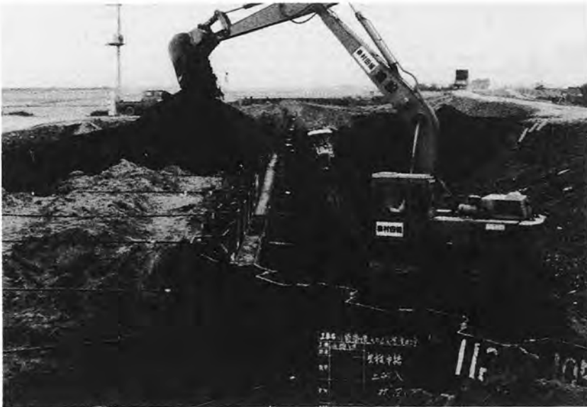
二重締切の中詰土砂敷均し状況 (川袋築堤)
