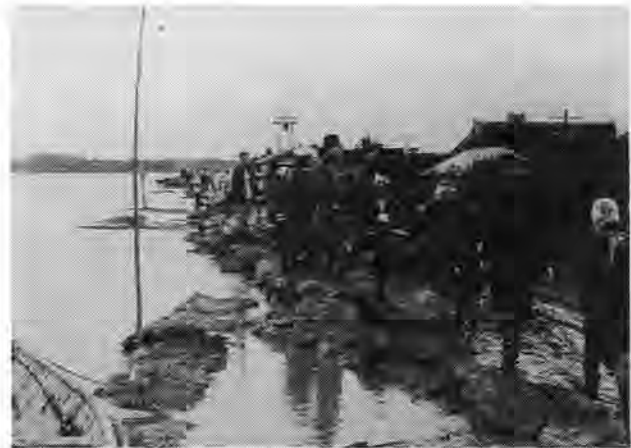
土のう積で越水を防いだ岩木川右岸堤防(上長泥)
