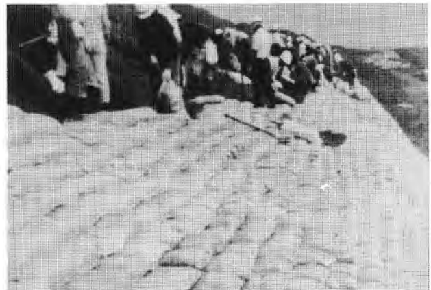
応急復旧、土のう施工（豊富築堤）
