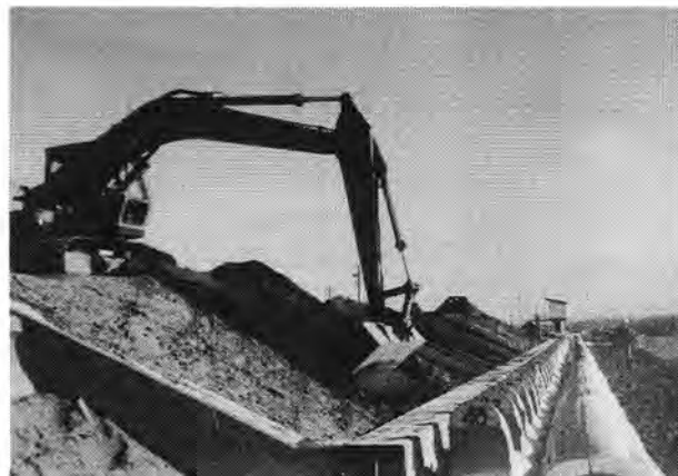
法覆工施工（右岸囲繞堤）
