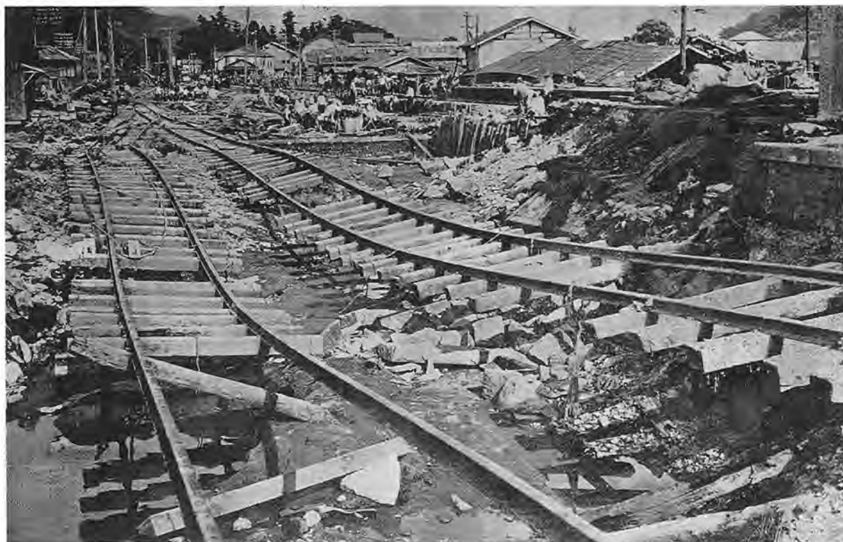
昭和10年8月洪水 濁流の後の大鰐駅構内
