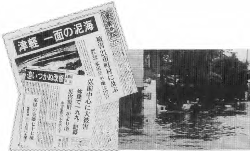
弘前市川端町の水害状況（土淵川）
