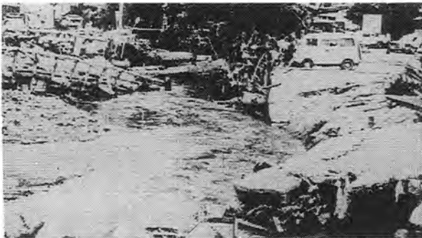
土淵川中流沿岸の惨状（西川岸橋下流）（弘前市）
