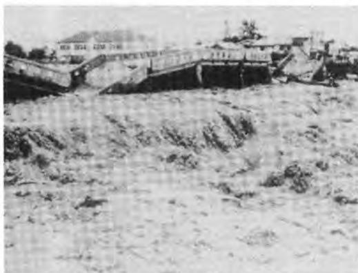
濁流により崩壊した千歳橋（浅瀬石川）
