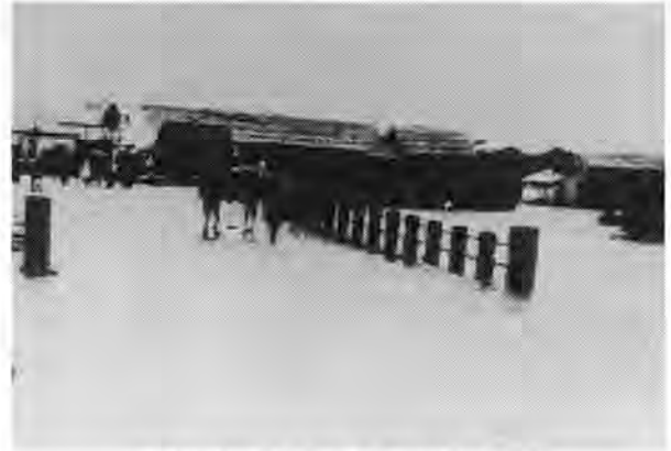
浪岡川の氾濫により水面下に没した橋梁
