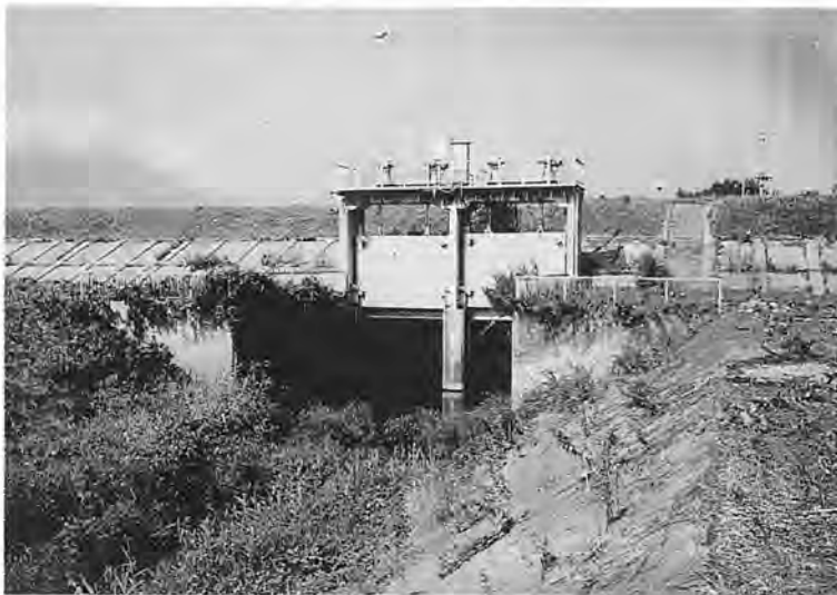
現在の川村水門
