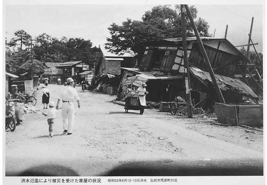
洪水氾濫により被害を受けた家屋の状況 弘前市馬屋町付近 昭和33年8月洪水 (52cm x 37cm)
