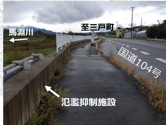
氾濫抑制施設施工状況
