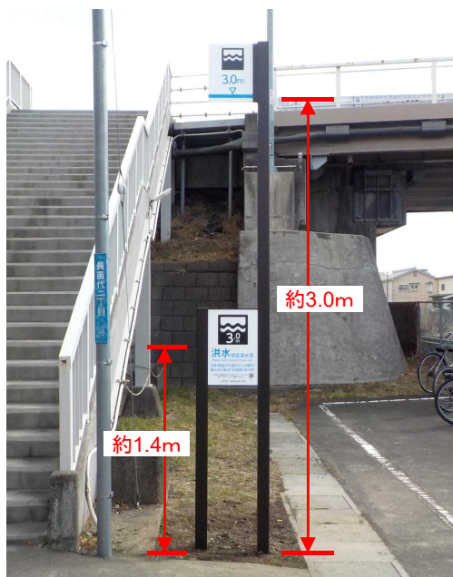
【設置状況 (JR長苗代駅)】
