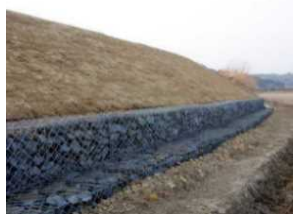
浸透対策の施工事例
