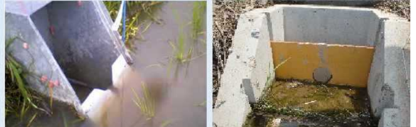
流出を抑制する「田んぼダム用堰板」の例
