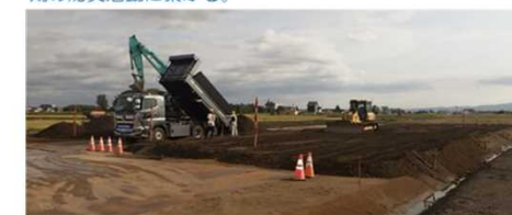
▲河道掘削土砂の搬入及び道路盛土施工状況
