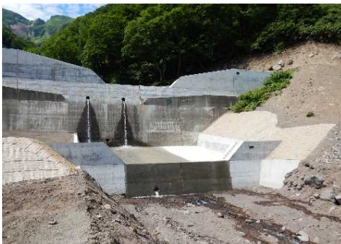
【治山:溪間工(治山ダム)】
