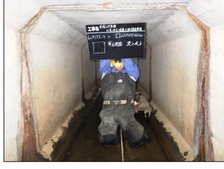
【暗渠の内部点検・補修の実施】
