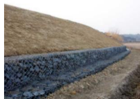
浸透対策の施工事例
