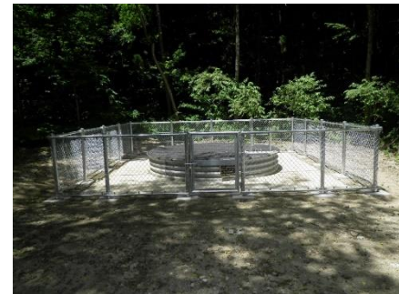
【地すべり防止工】
