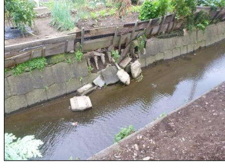
【護岸補修の実施】
