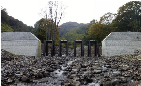
【治山:渓間工(鋼製スリットダム)】
