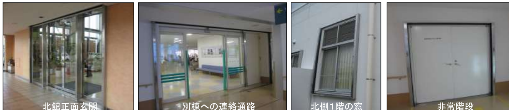
止水板のための角落としての設置
