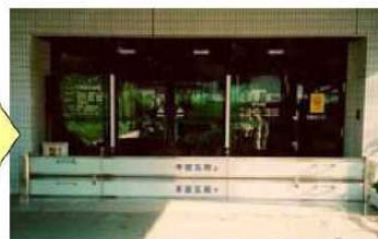
本館玄関への止水板設置状況（設置後）
