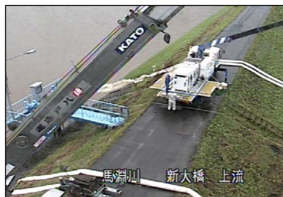
馬淵川の新大橋付近における内水排除作業状況
