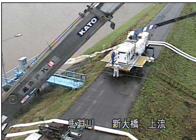
洪水時内水排除作業
