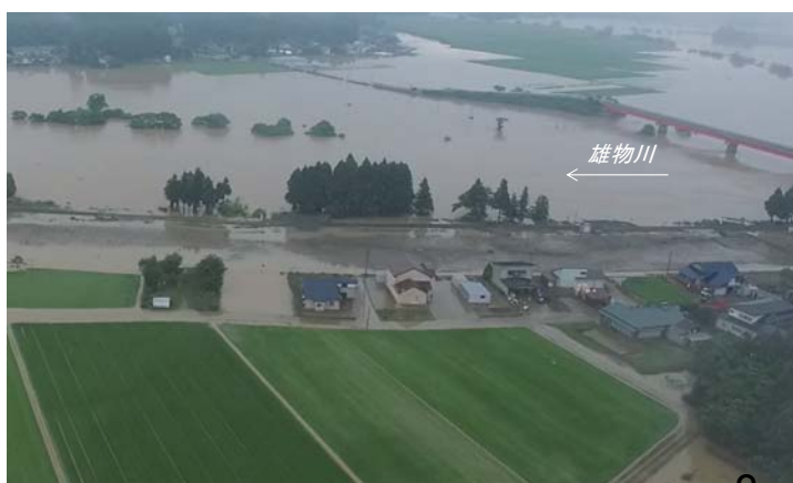
秋田県秋田市新波地区の被害状況 (平成29年7月23日撮影) 3
