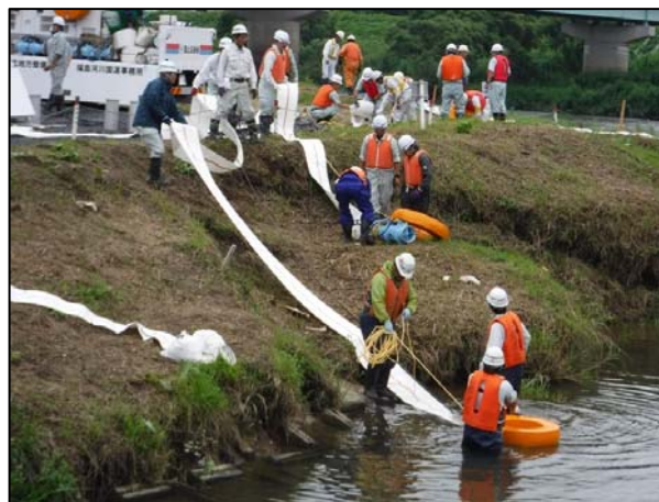
排水ポンプ始動訓練
