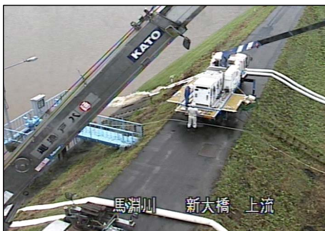
洪水時内水排除作業
