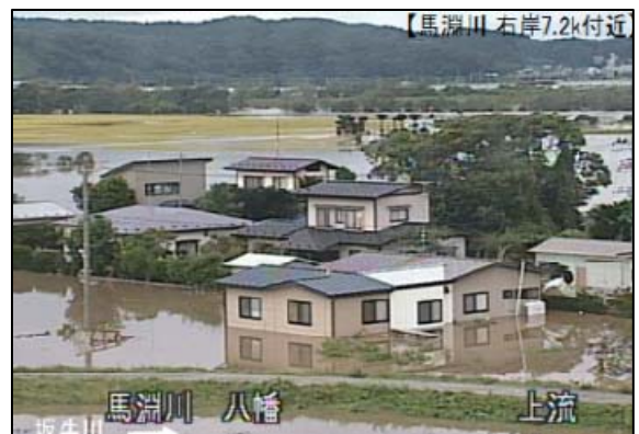
平成23年9月豪雨で浸水した八幡地区
