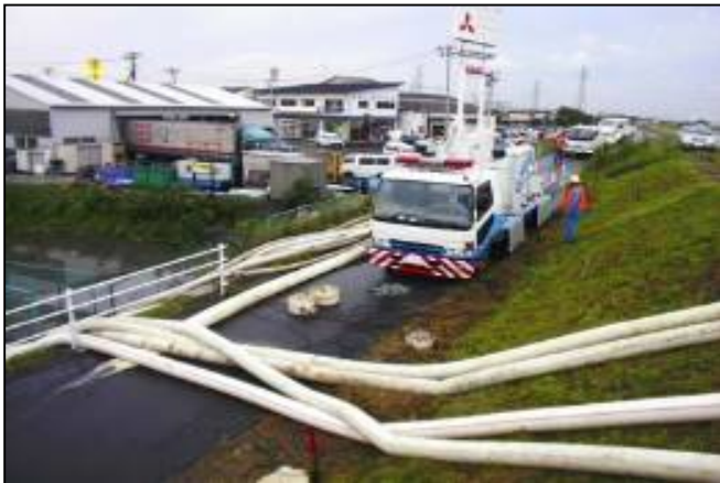
排水ポンプ車による排水作業
