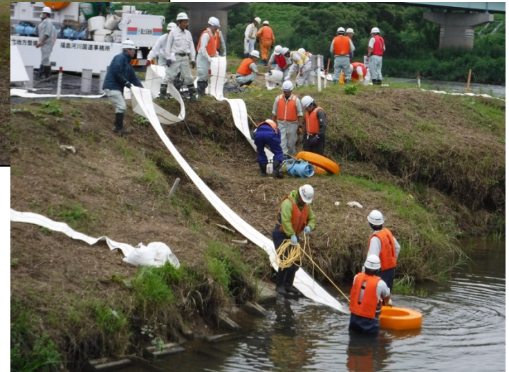
排水ポンプ車設置訓練状況
