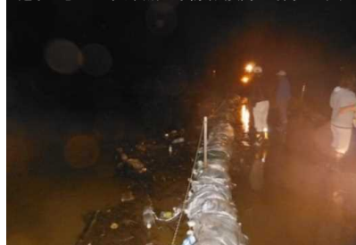
越水の恐れがある箇所の水防活動（鶴田町鶴田地先）
