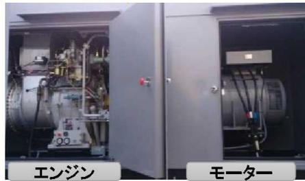
浸水への対策例：屋上に**非常用電源**を設置
