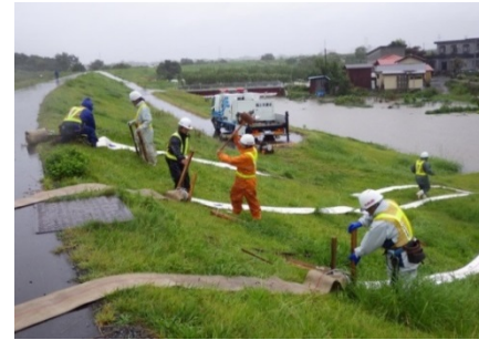
排水ポンプ車による排水作業（鳴瀬排水樋管）
