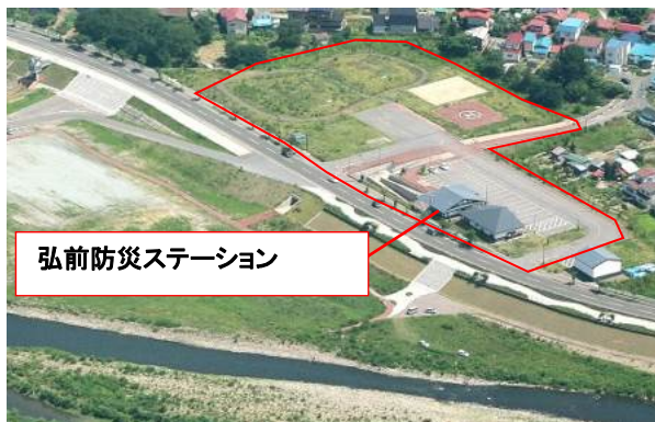
防災ステーションの整備
