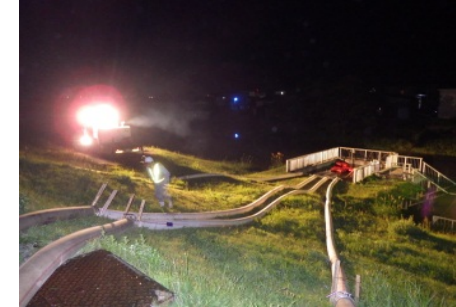
排水ポンプ車による排水作業（鳴瀬排水樋管）
