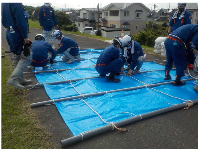
【馬淵川(7月21日35名参加)】 シート張り工の実施
