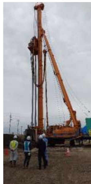
【七戸IC付近の地盤改良】
