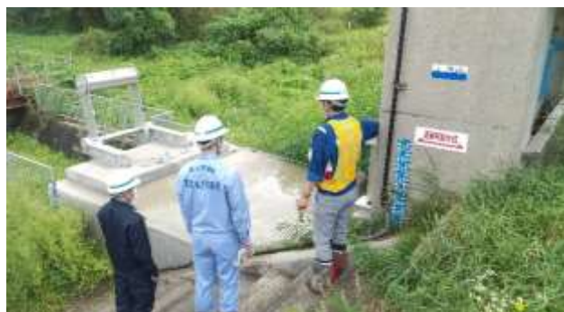
【後長根排水樋管】
