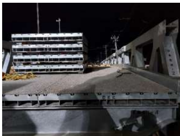
⑦【8月16日01:40頃 覆工板設置】
