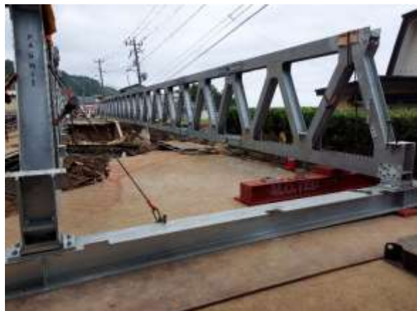
⑤【8月15日12:25頃 主構(トラス)設置完了】
