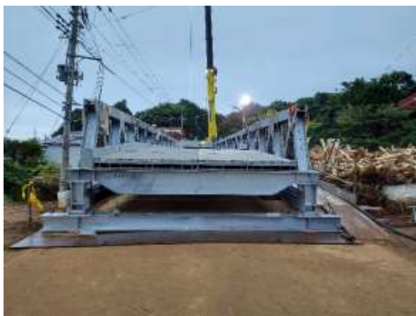
⑧【8月16日05:25頃 橋梁部完成】
