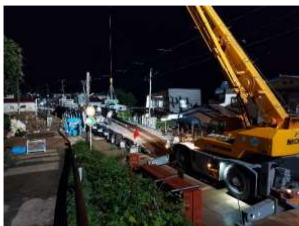
⑨【8月17日03:00頃 スロープ部施工】
