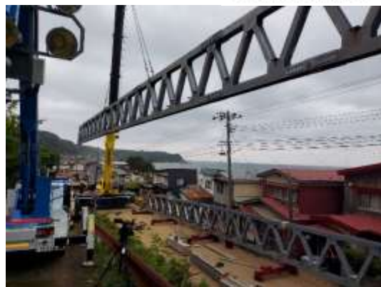
④【8月15日10:20頃 主構(トラス)の架設】
