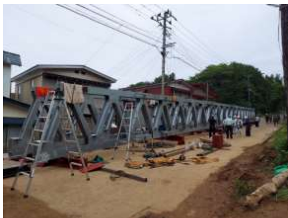
③【8月15日07:40頃 主構(トラス)の地組】
