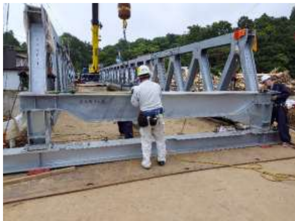
⑥【8月15日17:00頃 横桁設置】
