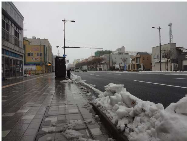
12/5(土)PM1:19 青森市堤町 国道4号の様子
