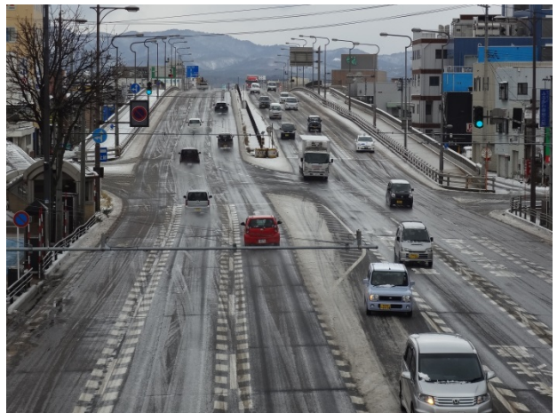
12/6(日)AM9:49 古川歩道橋から 国道7号の様子
