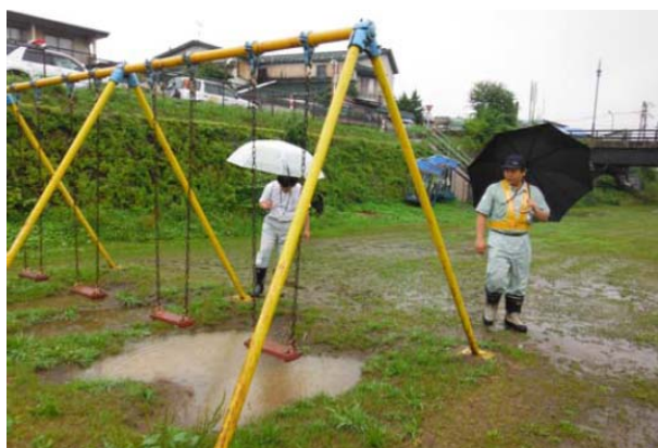
岩木川左岸の児童公園（弘前市藤代地内）で遊具の点検
