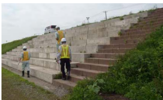
岩木川左岸つがる市柏総合グラウンド付近の点検状況
