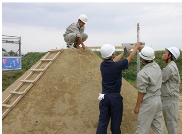
盛土の測量の様子
