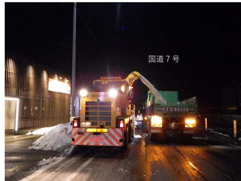
③ローリ-除雪車でダンプトラックに積み込み
