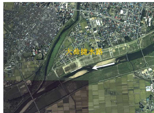
大曲捷水路完成後（平成 22 年）
