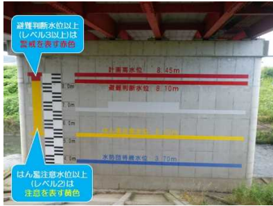
水位表示の例（橋脚）
