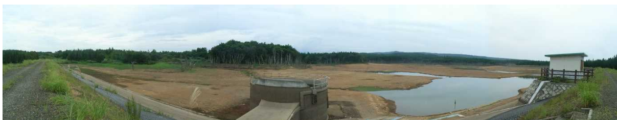
渇水で水位が低下した由利本荘市の黒森川貯水池 （出典：鳥海ダム工事事務所）
