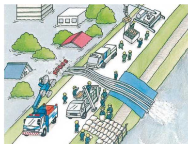
土のう、排水ポンプ車など (出典：近畿地方整備局)
