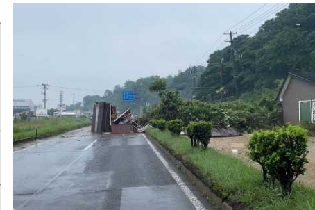
▲国道7号民地崩落
