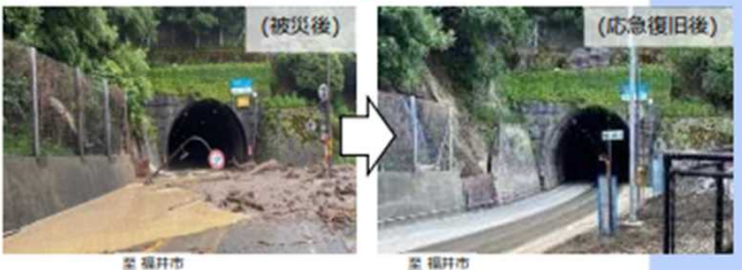
②国道8号大谷第2トンネル 土砂流入
