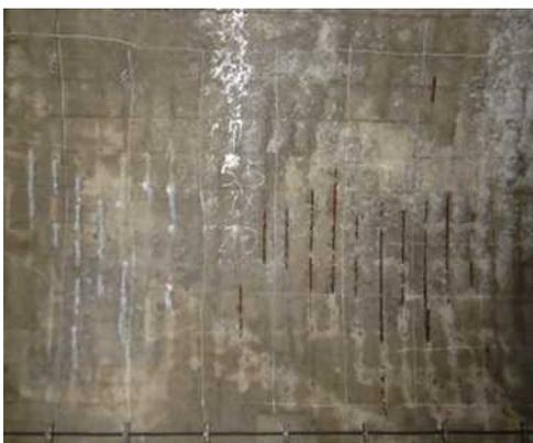
写真4-29 【損傷】鋼材腐食
