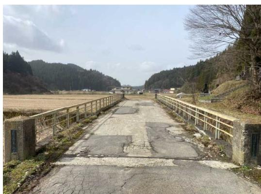
写真4-5 【損傷】橋面舗装ひび割れ
