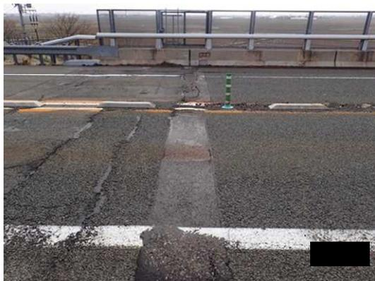
写真4-2 【損傷】伸縮装置の破損
