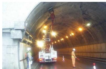
写真2-2 トンネル点検状況
