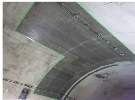
写真4-30 【対策】はつり、防錆処理、剥落対策
