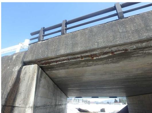
写真4-11 【損傷】主桁の鋼材露出
