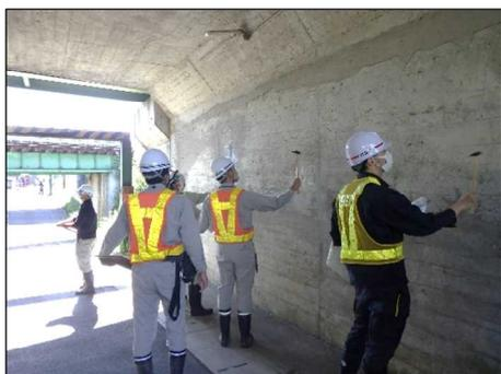
写真5-1 溝橋点検における点検実習
