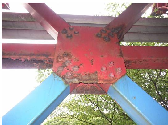
写真4-32 【損傷】鋼部材の腐食
