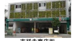
吉祥寺商店街共同集配送センター(東京都武蔵野市)
