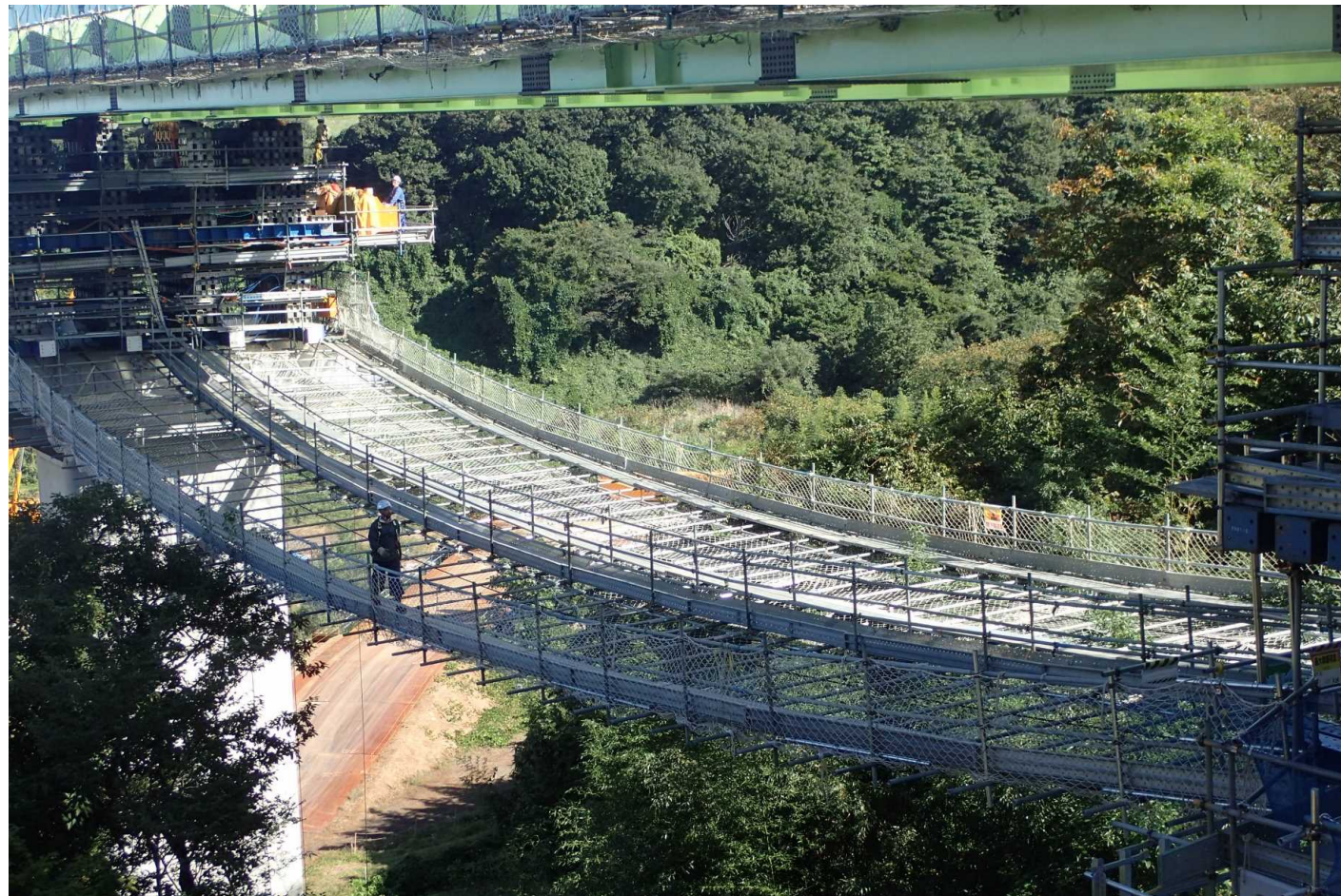
ワイヤーブリッジ足場
