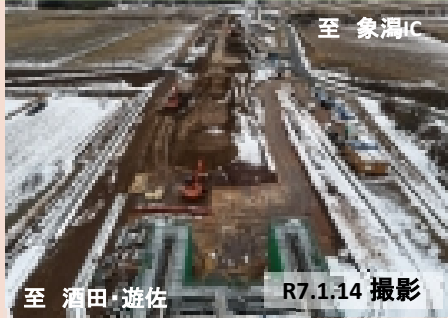
④ 大砂川地区道路改良工事
