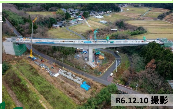
④ 川袋小川橋上部工工事
