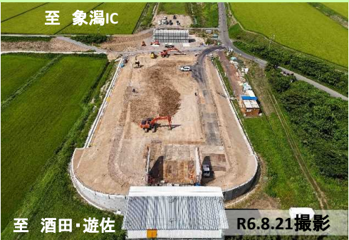
④ 川袋大田地区道路改良工事
