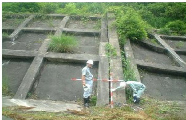
急斜地危険箇所のパトロール（法枠の縦目地の開きを調査）
