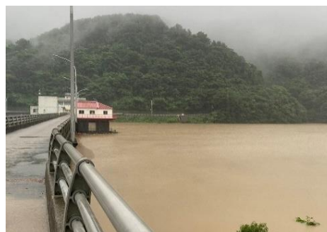
岩見川柳町水位観測局水位状況
