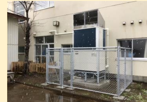
空調設備の基礎嵩上げ
