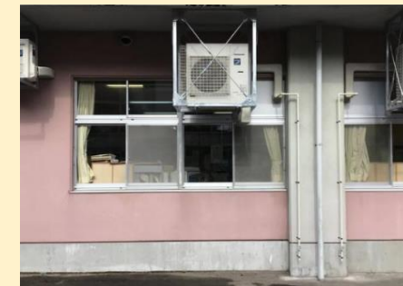
エアコン室外機を吊り下げ設置
