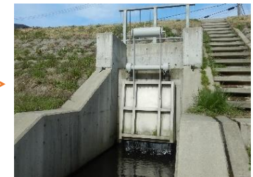
整備後(フラップゲート設置)
