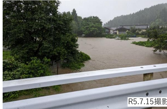
新城川浸水状況
