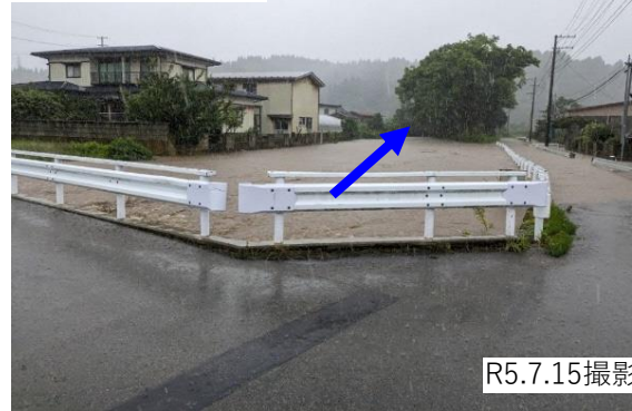
新城川浸水状況
