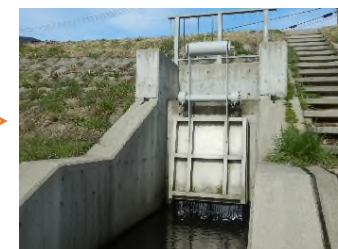
整備後 (フラップゲート設置)
