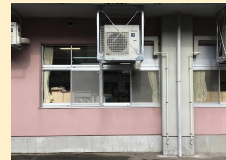
エアコン室外機を吊り下げ設置
