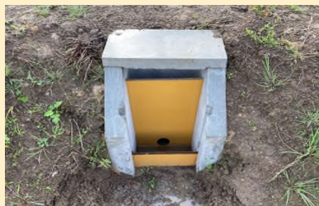
田んぼダムに対応した田面排水柵・水位調整板のイメージ
