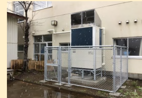
空調設備の基礎嵩上げ
