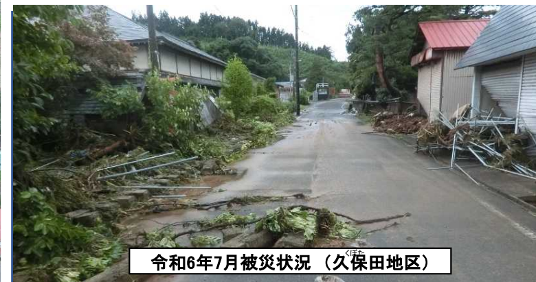
令和6年7月被災状況（久保田地区）
