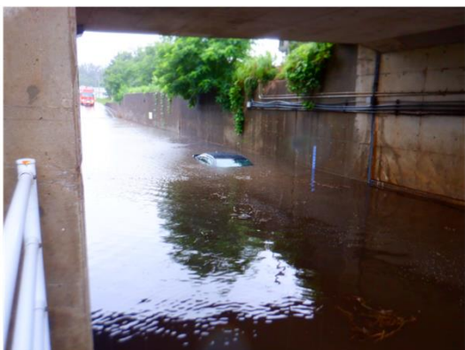
令和6年7月 アンダーパス冠水状況
