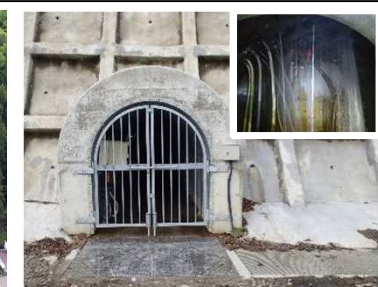
地すべり防止工
