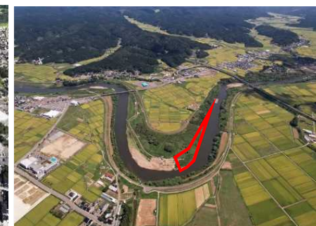
▲河道掘削 二十六木地区
