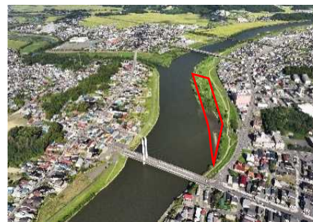
▲河道掘削 本荘地区 ほんじょう
