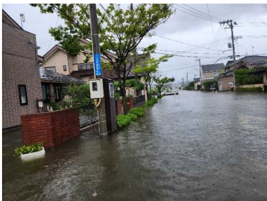
令和6年7月 宅地浸水状況
