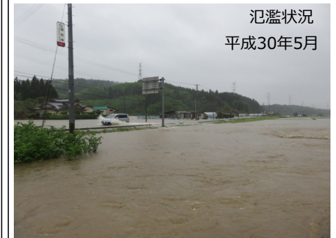
出水による被害状況
