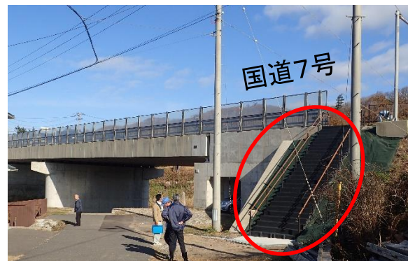
①避難路(階段)R3.3月完成
