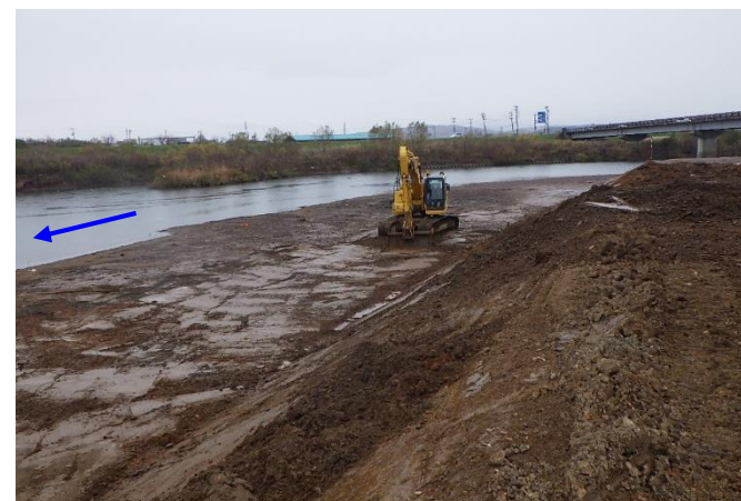
▲河道掘削状況
