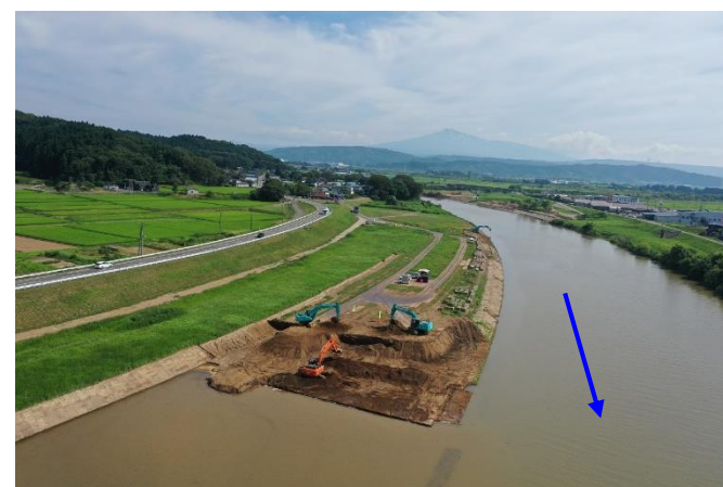
▲河道掘削状況
