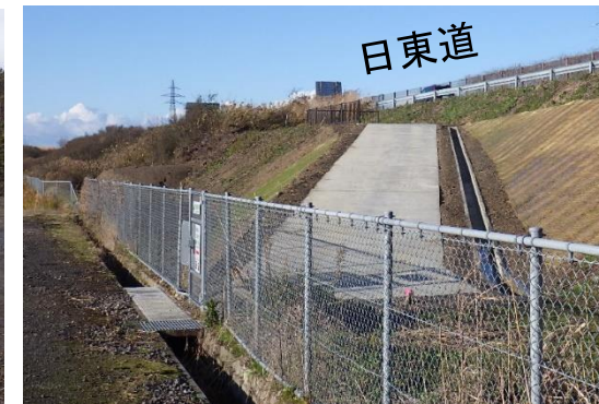
③避難路(スロープ)R3.12月完成
