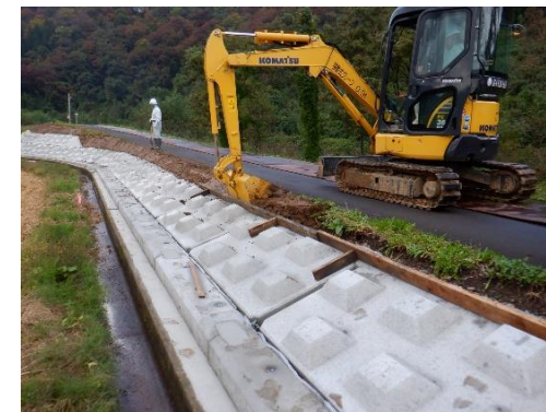
▲堤防裏法尻補強状況
