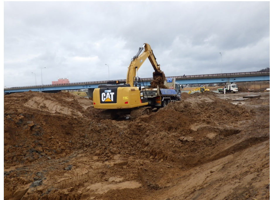
掘削土砂積み込み
