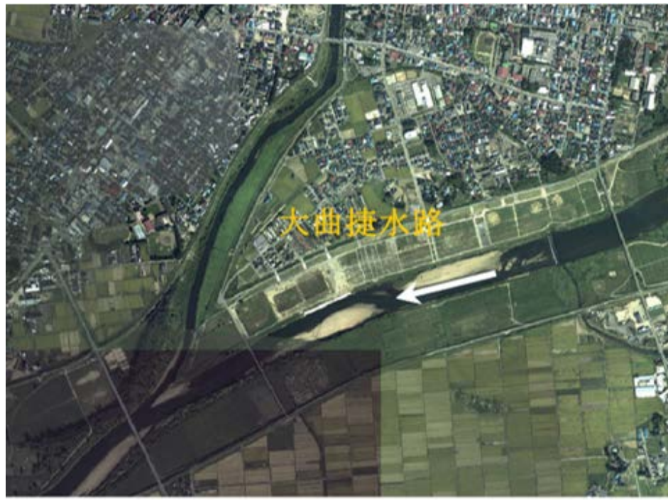
大曲しょう水路完成後（平成22年）
