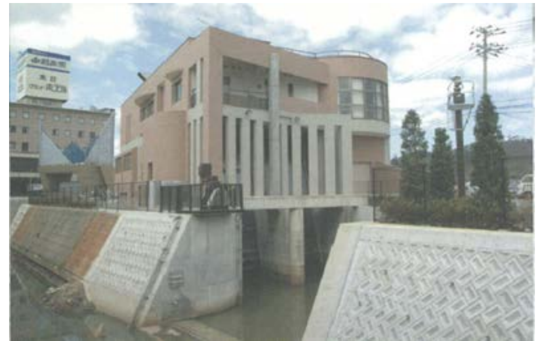
大沢川排水機場吸水口
