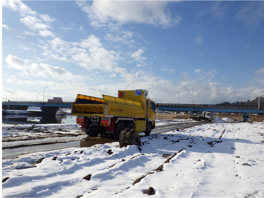
掘削土砂運搬
