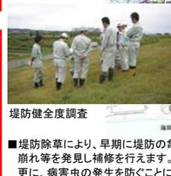
■堤防除草により、早期に堤防の亀裂や斜面の崩れ等を発見し補修を行います。更に、病害虫の発生を防ぐことにも繋がります。
