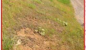
モグラ穴による堤防空洞化
