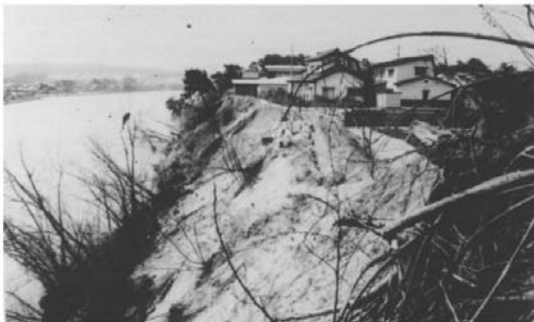
旧本荘市(尾花沢地区)の崩落した河岸 出典：秋田河川国道事務所資料
