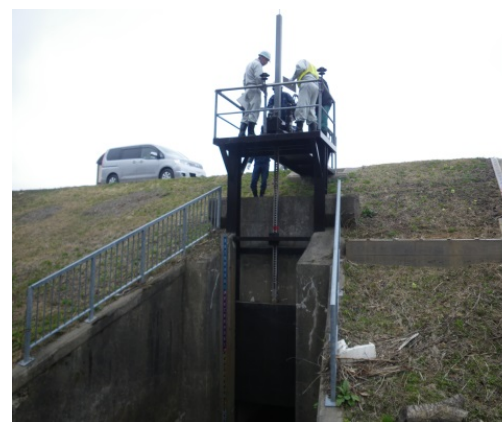
樋管点検状況
