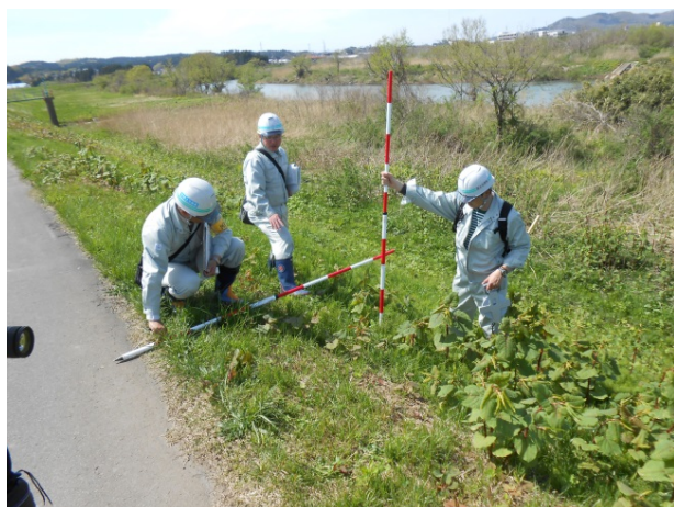
堤防モニタリング状況 (平成26年5月)
