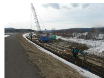
遮水矢板打込状況 (久保田地区)
