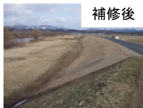
堤防補修(芝張替)状況 (平成26年10月)
