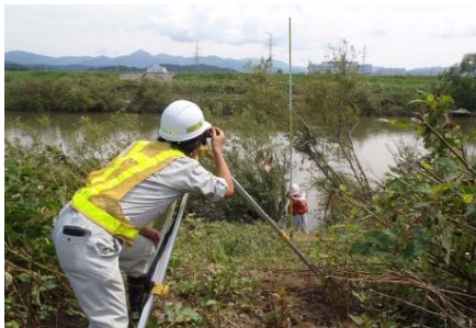
定期横断測量状況
