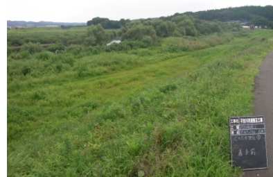
樹木伐採前 (平成26年8月)
