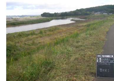
樹木伐採前 (平成26年10月)
