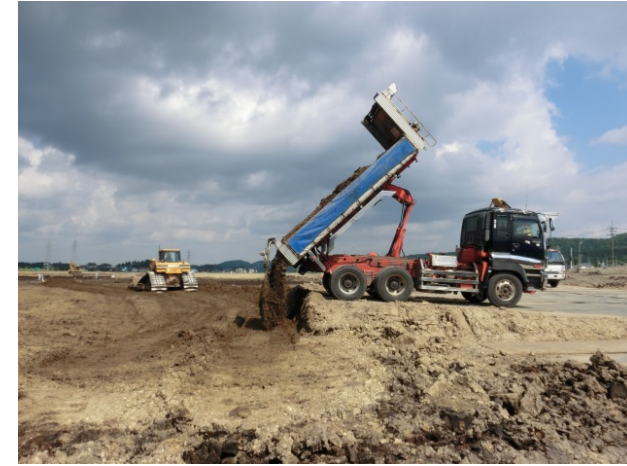
掘削土を造成材に活用
