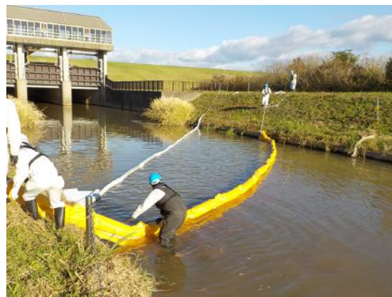
オイルフェンス設置訓練 (R4.10)
