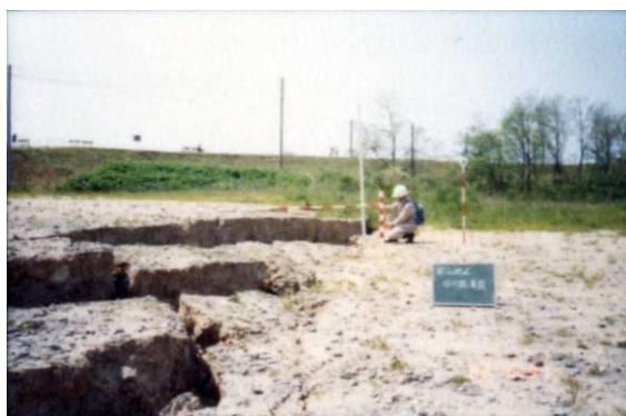
河川管理施設の点検例（日本海中部地震時の雄物川の事例）
