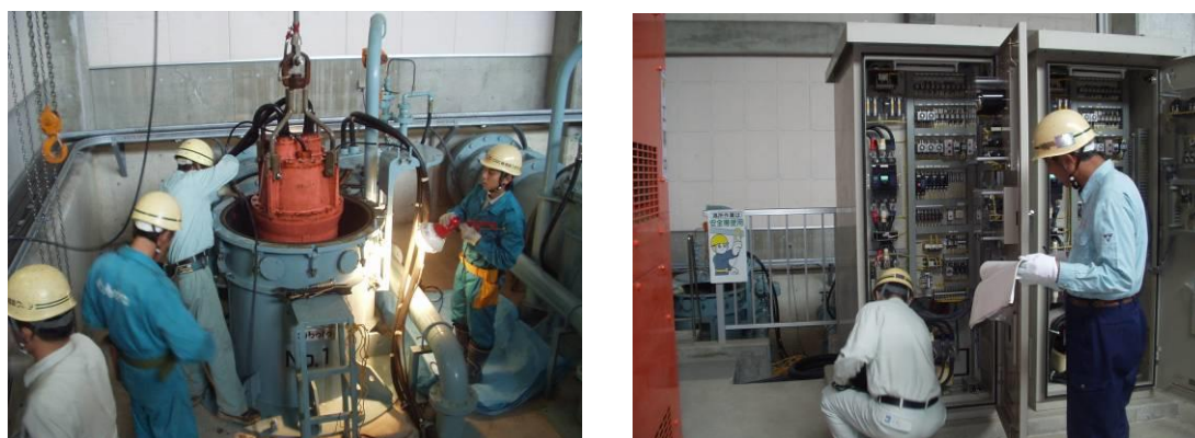
排水機場内の点検・調査状況
