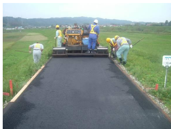
堤防天端の舗装
