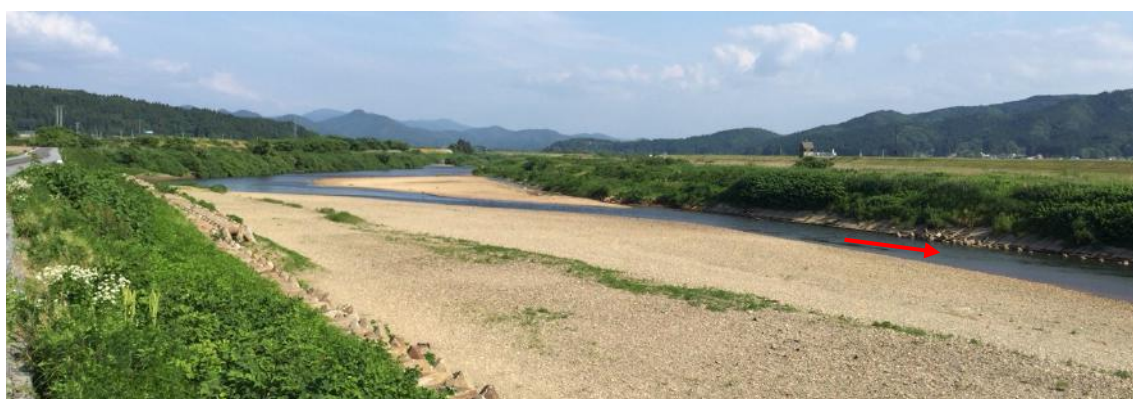
渇水時の子吉川（平成27年・石沢川合流点付近）
