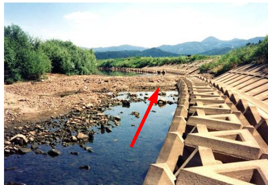
渇水時の子吉川（平成6年・石沢川2.0km付近）
