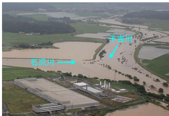
石沢川合流点付近の氾濫の様子
