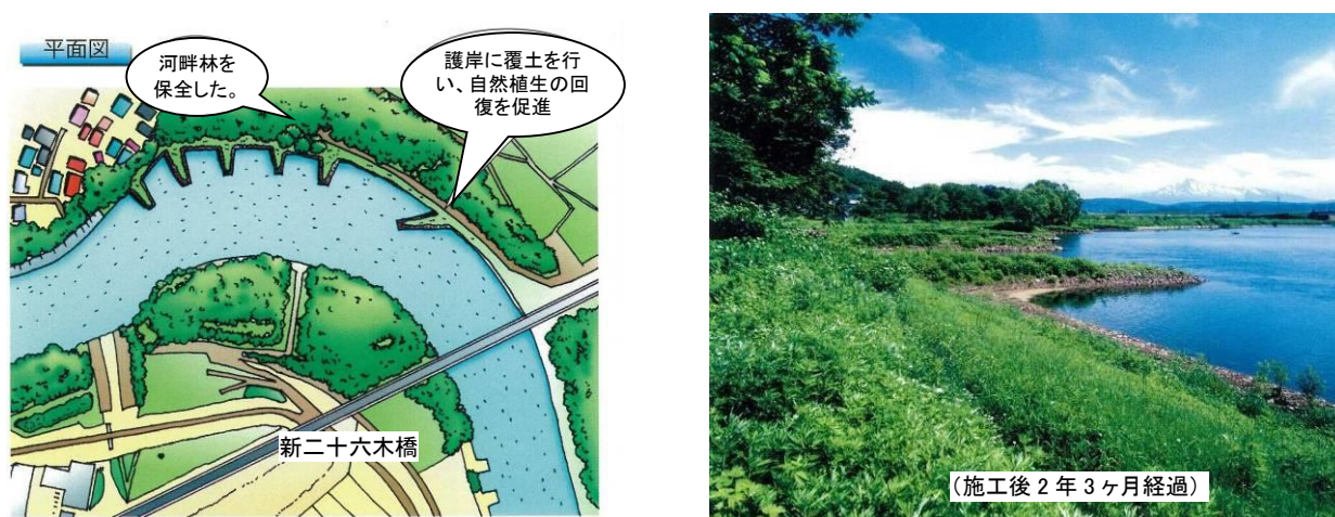
図 5-14 二十六木地区水制工 (7.2～7.4k 右岸) の事例
