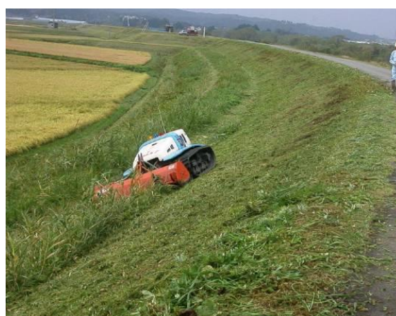
堤防法面の除草
