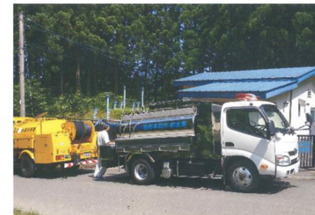
給水車による原水槽への補給状況
