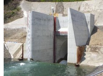
②転流工工事（仮排水トンネル） 呑口坑門工完了状況
