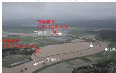
二十六木橋上空から上流側を撮影
