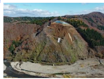
④右岸上部掘削工事 掘削状況
