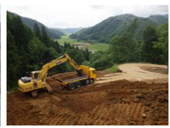
⑤付替道路工事 大膳ヶ沢地区施工状況
