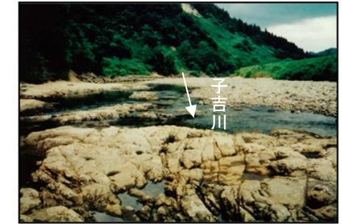
吉沢地区(21.2km付近)の状況
