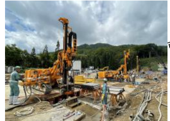
③転流工工事（地中壁） 地中壁施工状況
