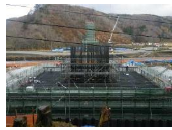
⑥付替道路4号橋下部工工事 P3橋脚施工状況
