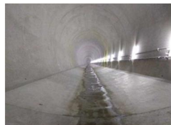
①転流工工事（仮排水トンネル） コンクリート巻き立て工完了状況
