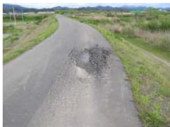
堤防天端の舗装の劣化状況
