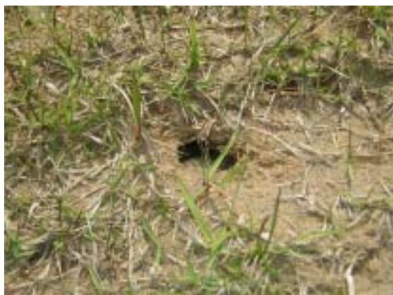
**モグラ穴による堤防の損傷**
