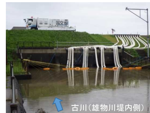
▲秋田市仁井田地区における排水ポンプ車による排水状況(7/28 15:30頃撮影)
