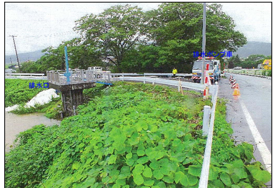
▲排水ポンプ車による排水状況
