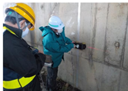
▲コンクリートビューによる塩分測定
