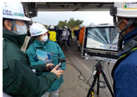
▲ドローンからの映像を確認しながら操作
