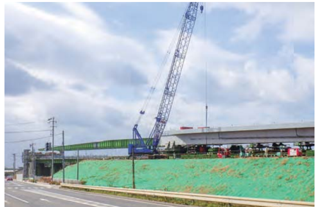
②下浜桂根橋 送り出し工法での橋桁架設状況(施工は深夜に国道7号を一時的に全面通行止して実施) H27.10撮影
