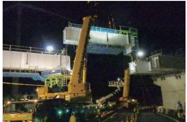
①羽川大橋 大型クレーンによる橋桁架設状況(施工は深夜に国道7号を全面通行止めして実施) H28.9撮影
