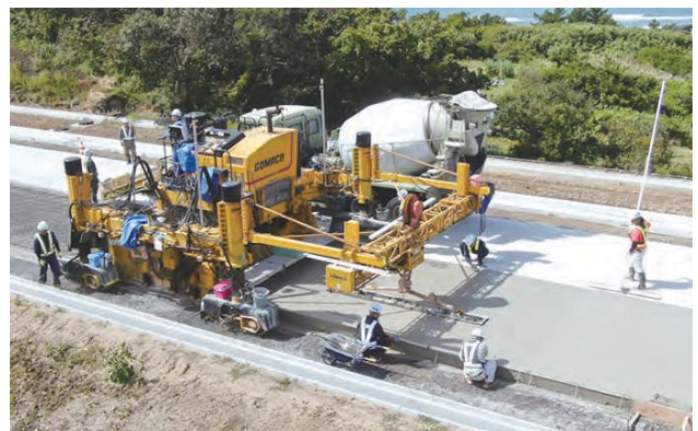
③連続鉄筋コンクリート舗装の施工状況 R元.9月撮影
