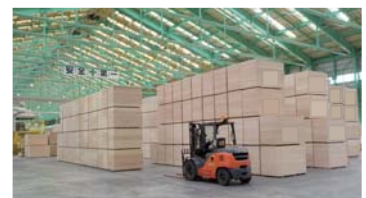
▲合板等製造工場内の様子
